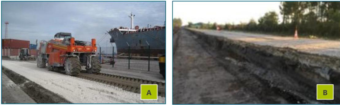
FIGURE 50 – REMPLI EN FILIERE ROUTIERE (A : ROUTE DU FREYCINET A DUNKERQUE - COLAS, 2012 / B : SITE DU TEICH A ARCACHON – SOLVALOR 2018)
