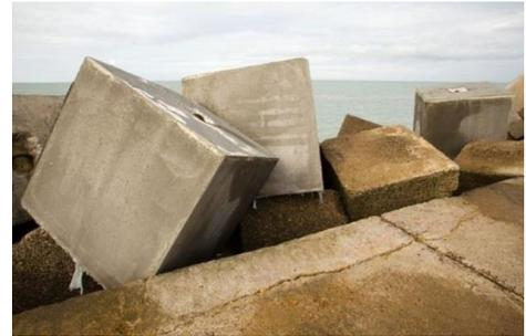
**FIGURE 52 – REMPLOI EN FILIERE BETON : ACROPODE AU GPM DE DUNKERQUE** (SEDILAB.SEDIMENTS.FR)
