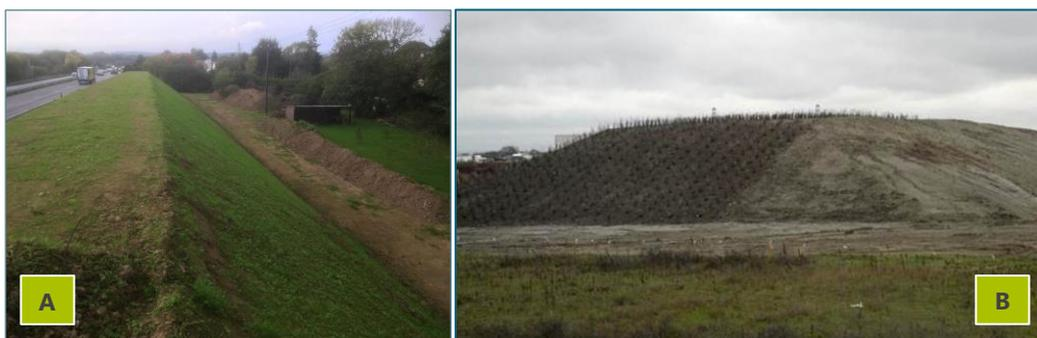
**FIGURE 42 – MERLONS PHONIQUE ET PAYSAGER (A : IDRA, LA TRINITE-SURZUR, 2018 / B : GPM DE DUNKERQUE)**
