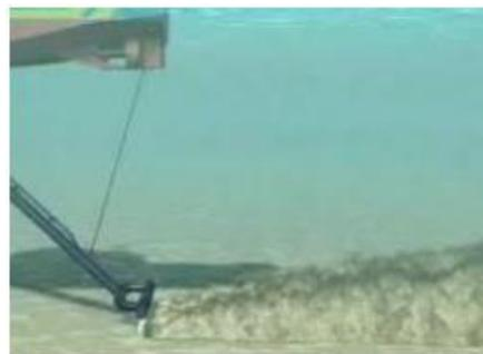
Lors d'une remise en suspension, le transport et le devenir des sédiments extraits repose sur la **distribution des courants "naturels"** tandis que pour une injection d'eau, le principe consiste à liquéfier localement le sédiment pour qu'un **courant de densité soit créé** (comme décrit §5.1.3 - ). Ce transport se "superpose" au courant "naturel" et peut beaucoup dépendre de la pente du fond et donc de la morphologie du terrain.
